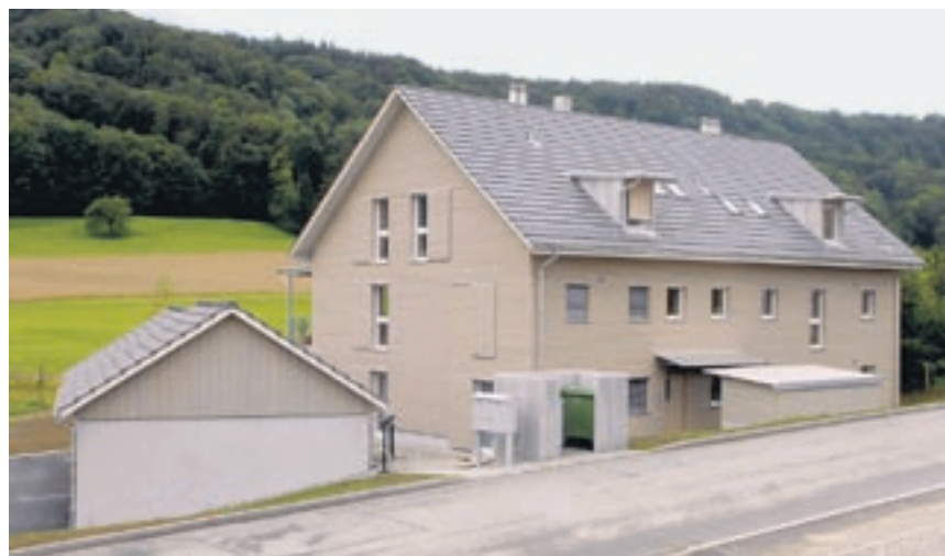
Unscheinbar, aber einzigartig: das erste Privathaus mit Glasfaseranschluss. Bild: hd
